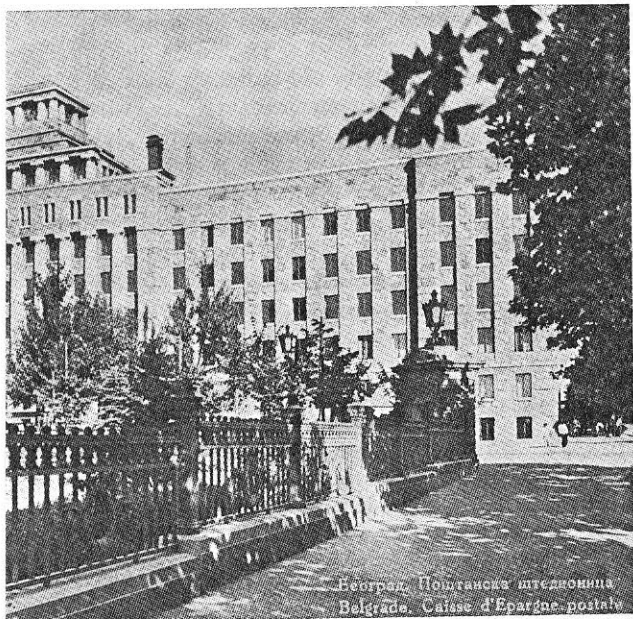
Зграда Поштанске штедионице, према Таковској улици, са закривљеном регулационом линијом, према Генералном плану, на месту пројектованом за зграду Београдске општине. Снимак непознатог аутора, око 1950. године.
