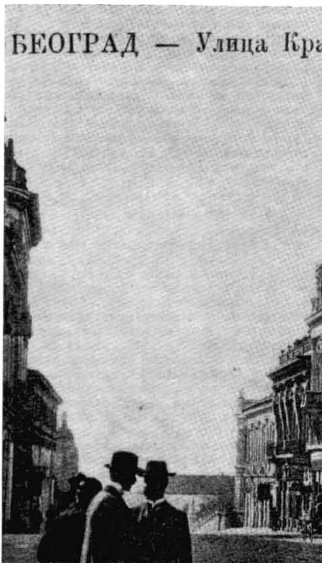
Београд 1934: Улица краља Петра I, данас Садмог јула; У згради на десној страни фотографије (улица 7. јула број 26) био је смештен Музеј и Библиотека Општине града Београда. Свечано отварање Музеја и Библиотеке Општине града Београда у овим просторијама обављено је 11. јануара 1931. године.
