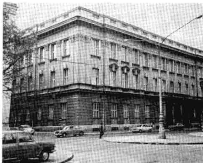
Зграда Новог универзитета (сада Природно-математички факултет) саграђена 1922. год. по плановима арх. П. Гачића. Данашњи изглед
