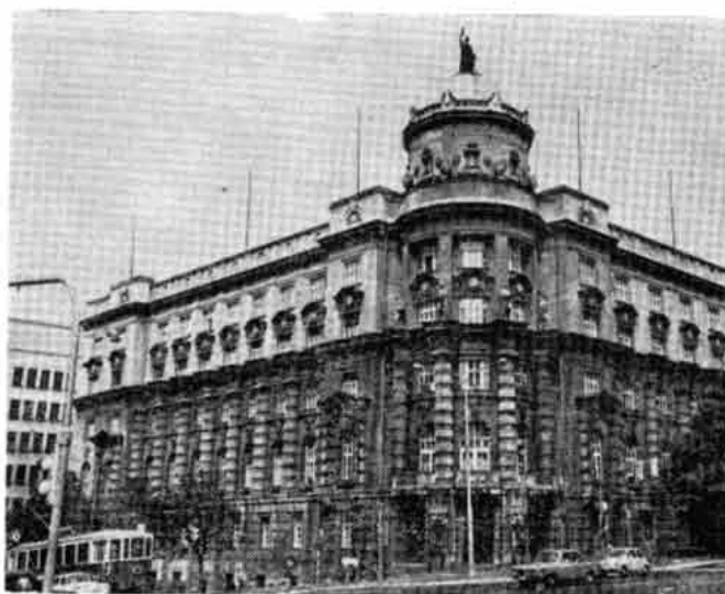
Le Ministère des finances, à l'angle des rues Kneza Miloša et Nemanjina. Bâti et ensuite réhaussé d'un étage sur les plans de l'architecte N. Krasnov (1925—1928)
