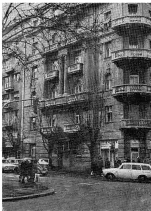
Стамбено-трговачка зграда на углу Булевару Револуције и ул. Светозара Марковића. Пројектант арх. А. Јанковић
