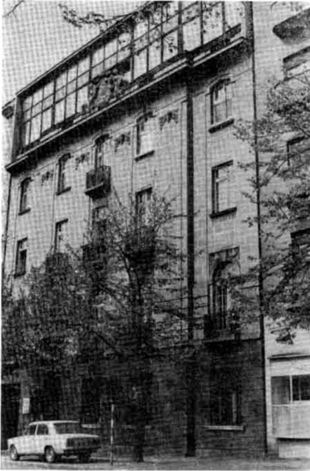
Стамбена зграда у Његошевој ул. бр. 19. Пројектант арх. А. Ђорђевић
