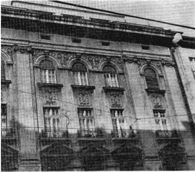
Монуменално и декоративно третирање фасаде. Зграда у ул. Бориса Кидрича (арх. М. Радовановић)
