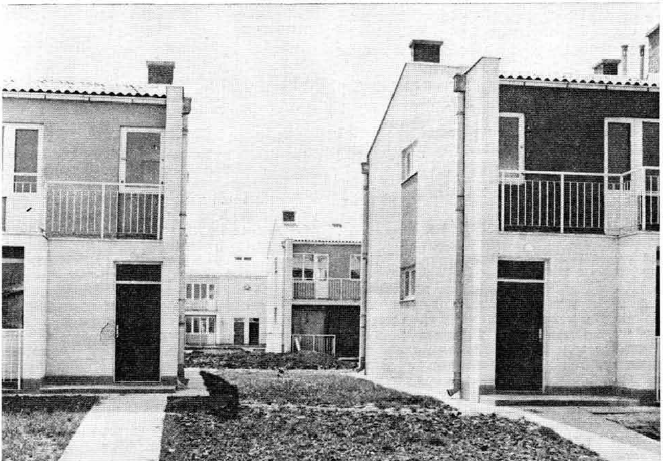
Certaines réalisations dans l'agglomération de Borča: les débuts (audessus); constructions actuelles (audessous)
