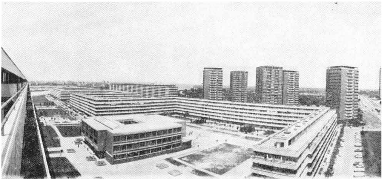
Нови Београд Нови реонски центар у изградњи. – Један од оформљених делова Новог Београда N. Belgrade Le nouveau centre de rayon en construction. - Une des parties terminées du N. Belgrade
