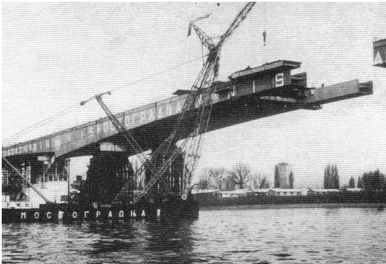
Мост „Газела“ у изградњи
