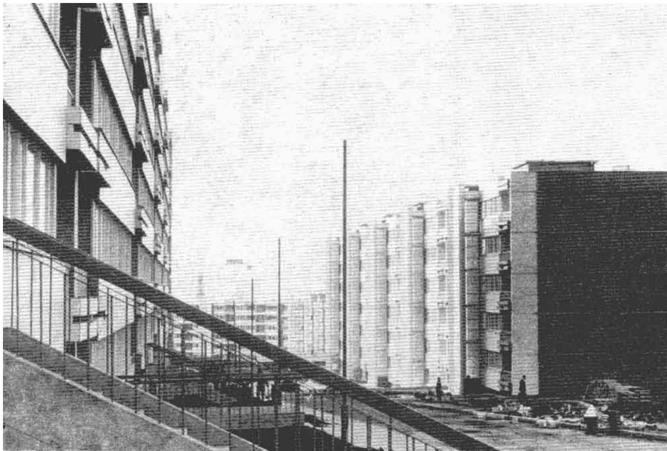
Коњарник у изградњи
