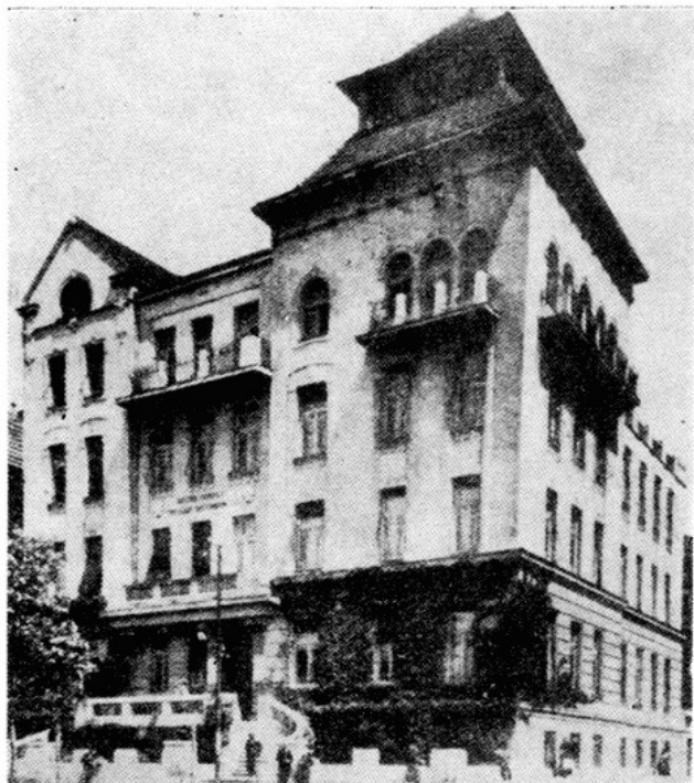
Градска поликлиника у Улици Пролетерских бригада 53. Сл. 17.
