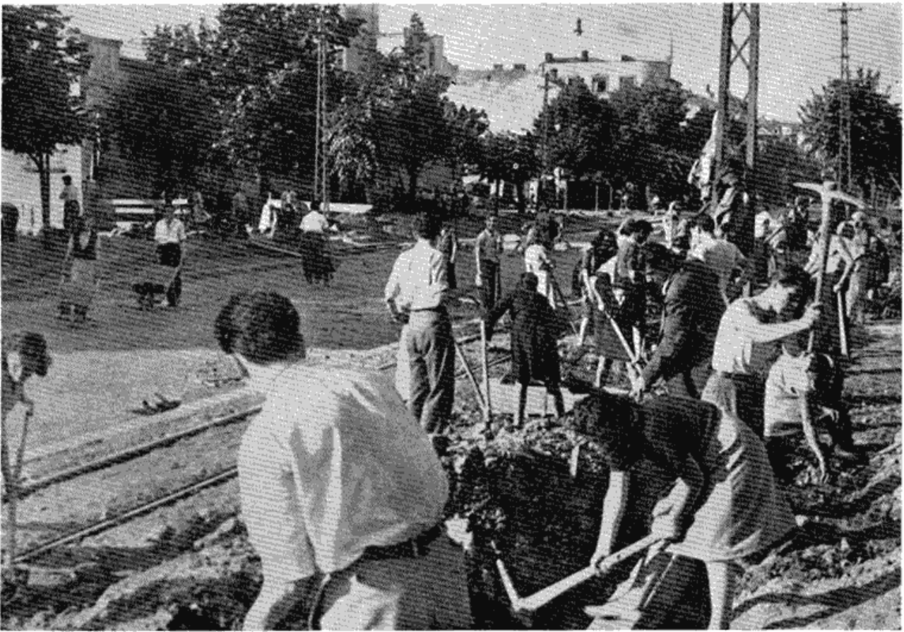
Сл. 12 — Радови на реконструкцији улице Кнеза Милоша.
