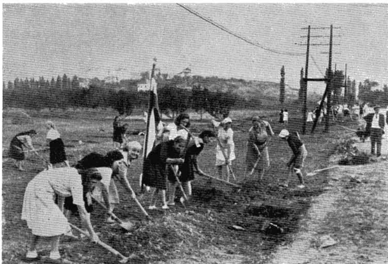
Сл. 19 — Акција на изградњи трамвајске пруге Топчидер—Раковица.
