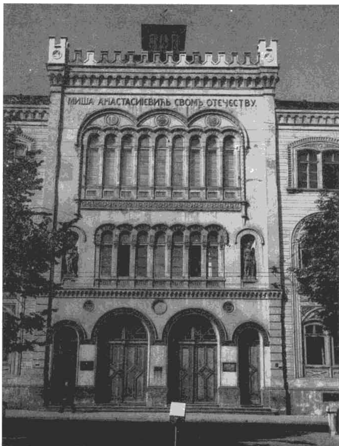
Сл. 9 — Средањи део главне фасаде
