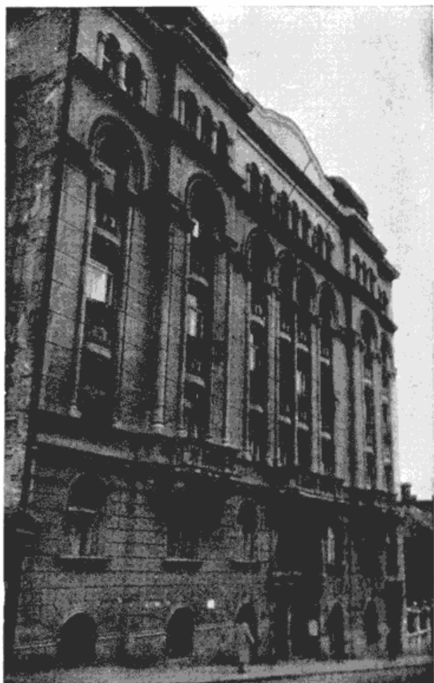
Сл. 9 — Дом културе општине Стари Град у улици 7 Јула бр. 71
