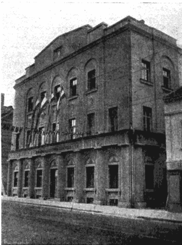
Сл. 7 — Зграда Народног одбора града Београда у Узун Мирковој улици, раније хотел »Круна« у коме се налазила школа Стеве Тодоровића
