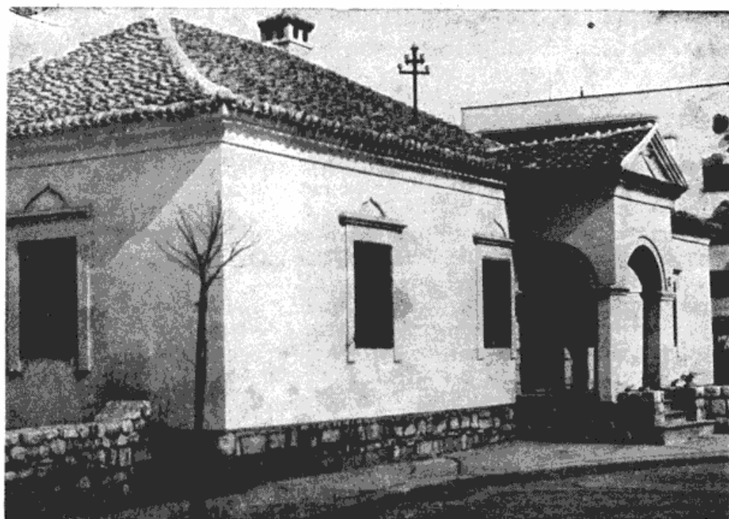
Сл. 2 — Божићева кућа, после извршених конзерваторско-рестаураторских радова
