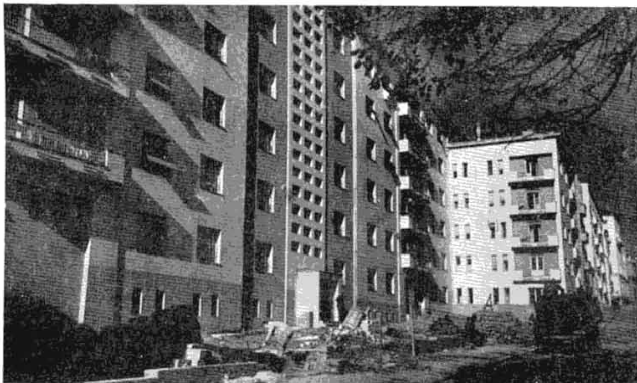
Сл. 4 — Станбене зграде у улици Алексе Ненадовића
